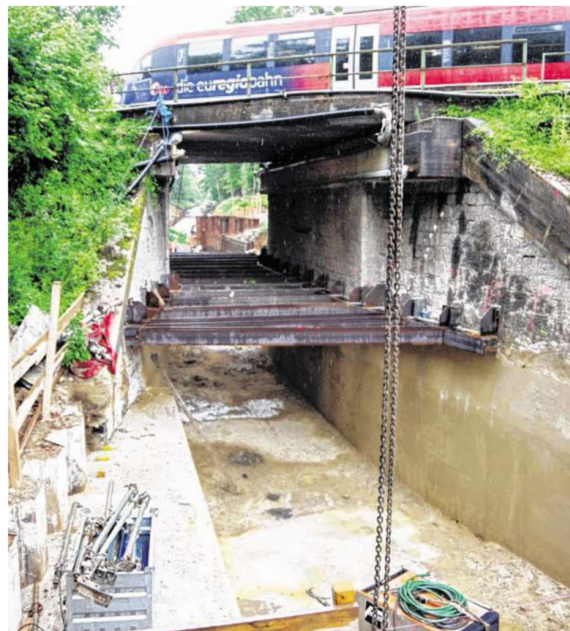
Die Bedeutung der Nebenstrecken wird bei der DB-Sommerbaustelle deutlich: Die Euregiobahn (r. u.) hilft, den Verkehr aufrechtzuerhalten. Vier Meter in die Tiefe reicht der Trog für das spätere Gleisbett im „Lehmsiefen“ (gr. Bild). Die Arbeiten am letzten Kilometer von dort bis zum Hauptbahnhof laufen bereits. Fotos: J. Lange
